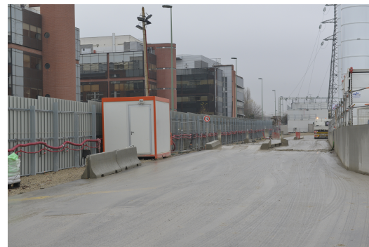
FIGURE 40 – Sortie chantier friche Arrighi On constate l'absence de palissades anti-bruit et la présence de boue en sortie de chantier malgré les lave-roues.
