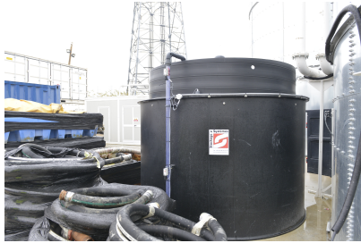
FIGURE 43 – Imbrication de cuves de stockage d'acide
