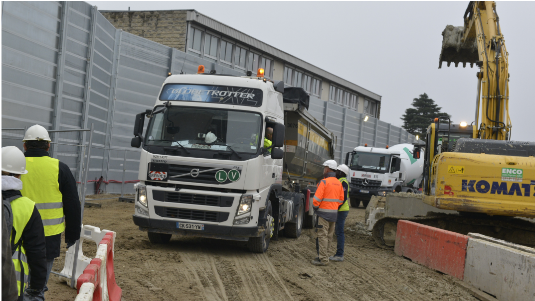
FIGURE 31 – Présence de hautes palissades sur le site de la gare de la ligne 14 sud Chevilly Trois Communes
