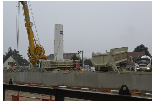
FIGURE 42 – Chantier de Chevilley Trois Communes
