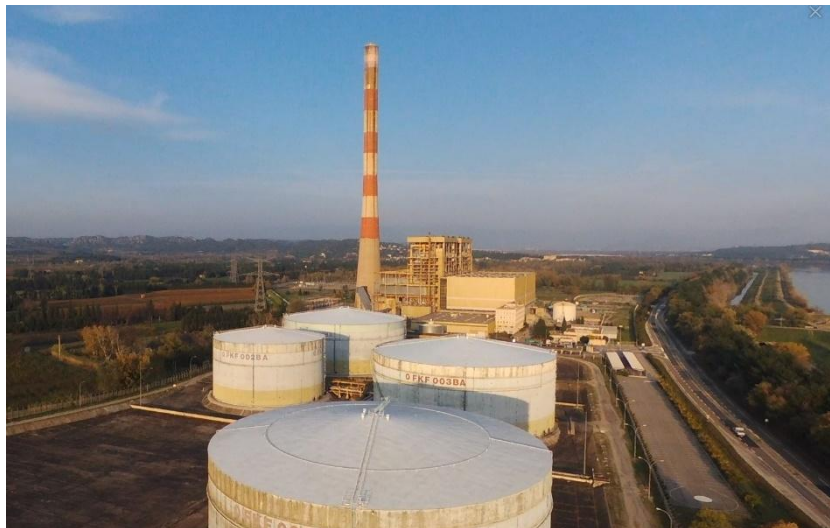
Figure 1 : Photo de la centrale d'Aramon
