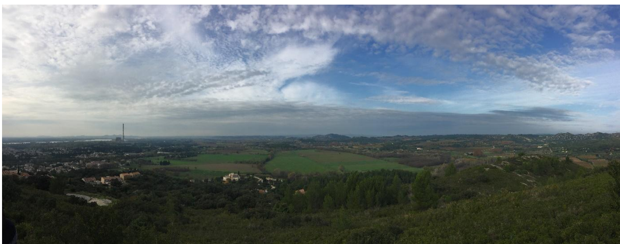
Figure 39 : Photo de la centrale d'Aramon
