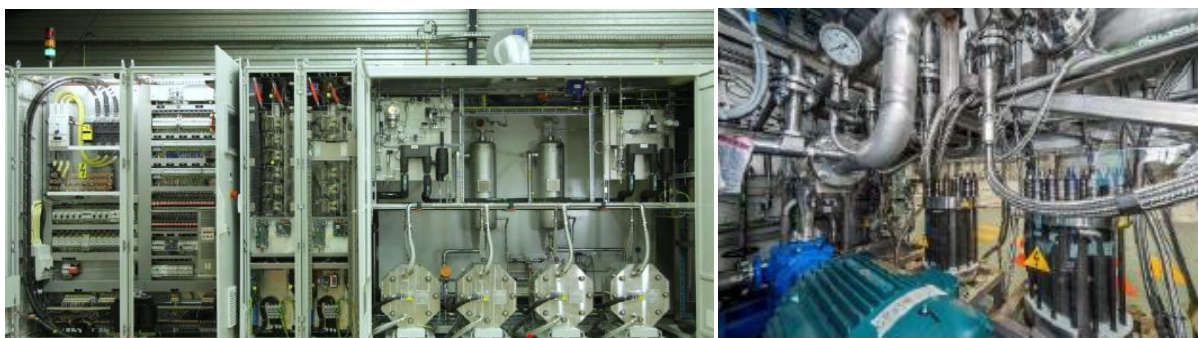
Figure A1.7. Station de production d'hydrogène et tuyauterie associée
