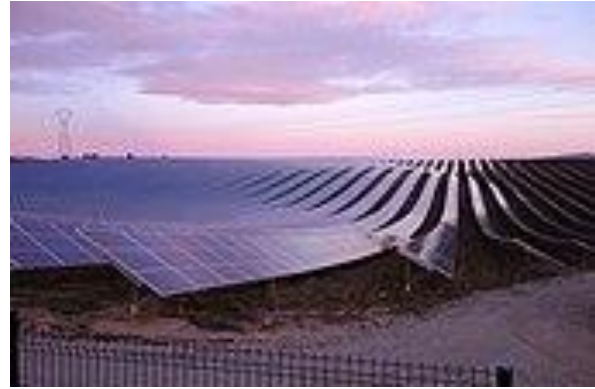
Figure A2.2. Parc photovoltaïque de la Colle des Mées, France
