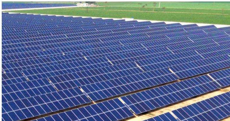
Centrale solaire équipée par Optimum Tracker
