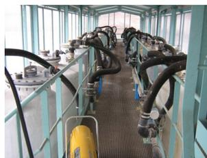
FIGURE 6 – Les colonnes de résines échangeuses d'ions de l'usine de traitement de Lodève dans l'Hérault (Orano)
