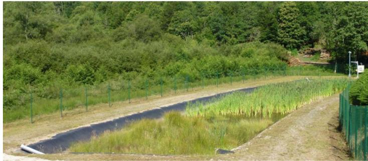
FIGURE 32 – Une tourbière pour le traitement passif des eaux (Orano)
