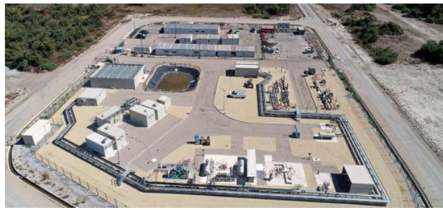
FIGURE 28 – Vue aérienne des installations du Projet JUPITER 1000
