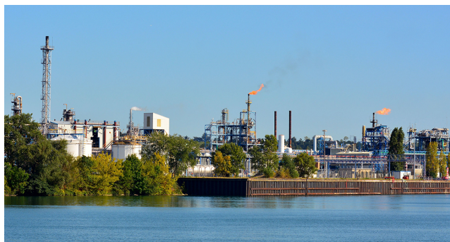
FIGURE 9 – Aperçu du bassin industriel de Fos-sur-Mer
