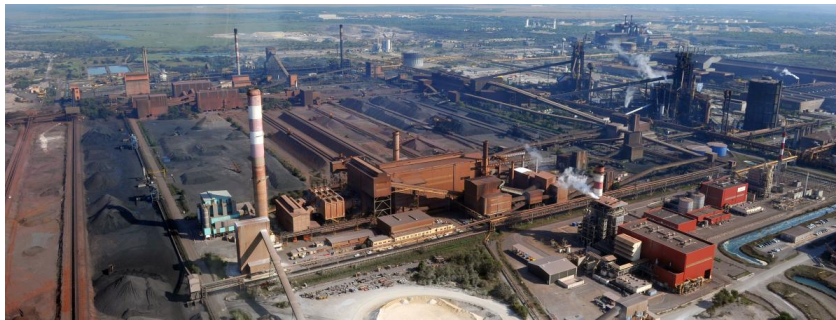
FIGURE 29 – Vue aérienne des installations d'ArcelorMittal
