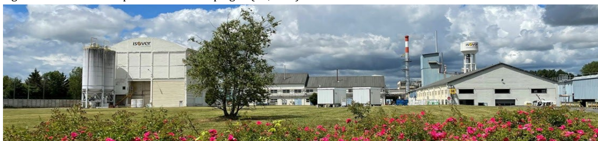
Figure 2 – CRIR situé à proximité de Compiègne (60, Oise).
